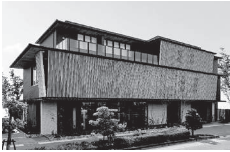
木造在来軸組工法+CLTパネル
