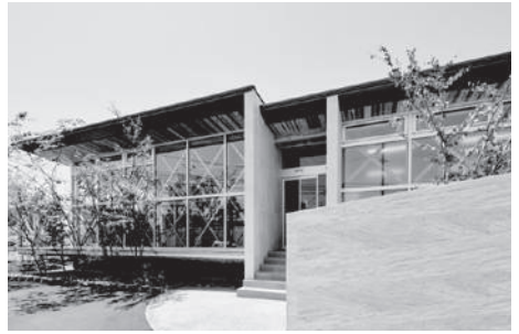
木造軸組工法+CLTパネル
